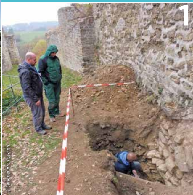
Untersuchung der Mauerwerkseinbindung in das Erdreich durch den Statiker.
