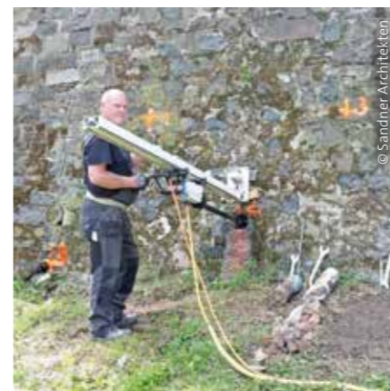
Kernbohrverfahren mittels Diamant-Hohlbohrkrone und Bohrlafette.
